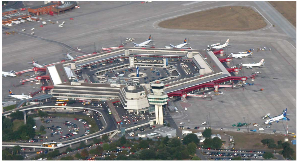
Ein internationaler Großflughafen benötigt unglaublich viel Energie und muss lückenlos versorgt werden ...
