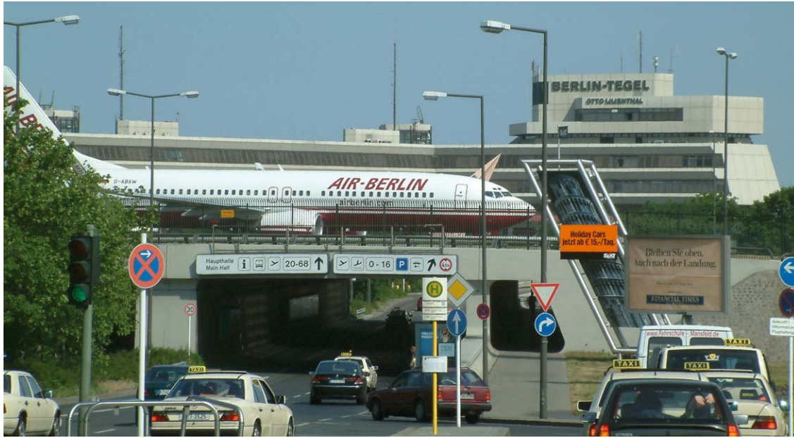
Der Flughafen Tegel ist einer der drei Berliner Flughäfen, die von K&P fit für die Energiedatenerfassung und -abrechnung der Zukunft gemacht wurden.
